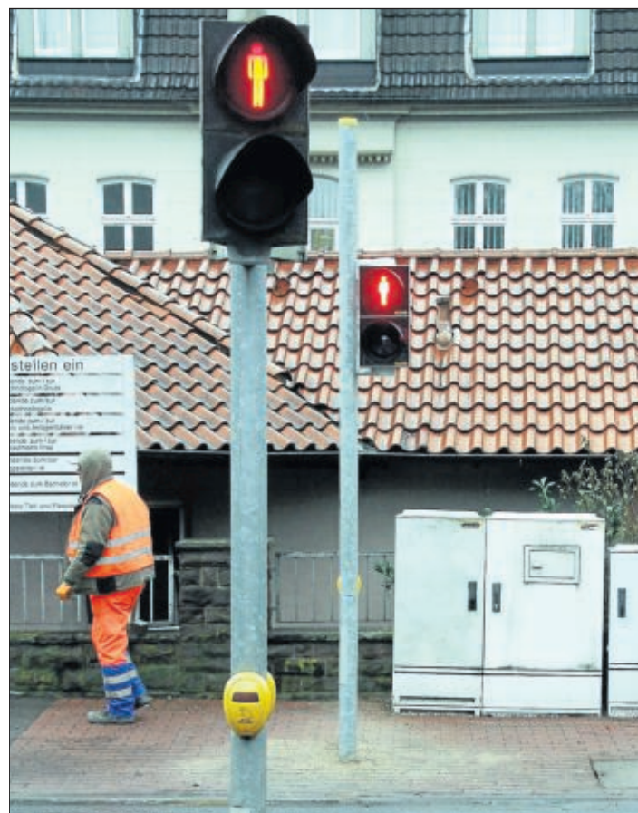
Überweg auf der Kasseler Straße zur Firma Haendler & Natermann: Die Fußgängerampel funktioniert wieder. Foto: Kruschmann
